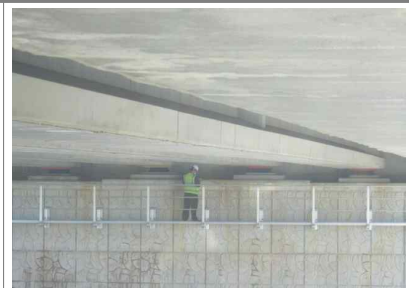
▲ 교량받침 점검로 근접조사
