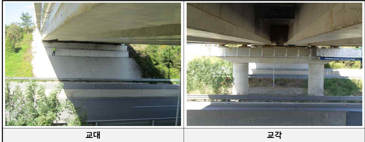
[교대 및 교각 전경]
